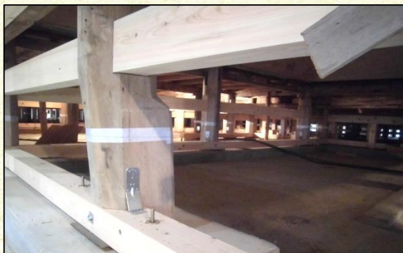
床下免震耐震補強工事
