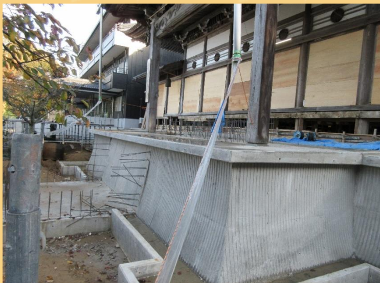
下 本堂を囲む基壇。新たにコンクリートを打設した。
